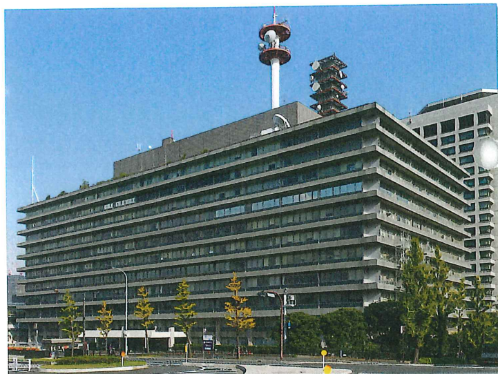
国土交通省などが入る中央合同庁舎3号館(引用元:国土交通省公式サイト)
